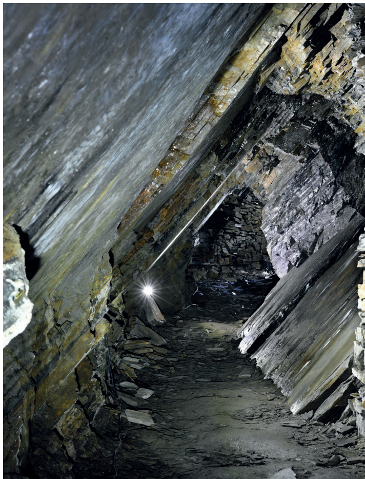
Zálužné; tzv. Raabova štola - zpřístupněný podzemní lom; foto J. Wagner
