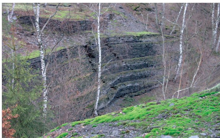
Zálužné; Opěrné zdivo odvalu nad cestou; foto autor
