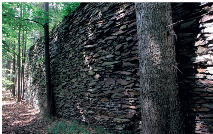
Kerhartice; Opěrná zeď pod odvalem; foto autor
