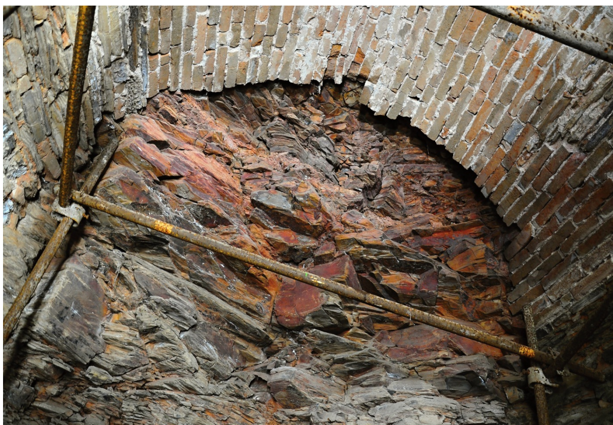
Zadná stena opustenej pivnice, na ktorej vystupujú bridlice (foto P. Ondrus)
