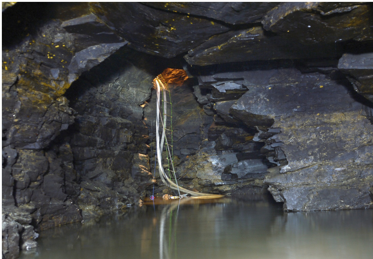
Súčasný vstupný otvor do štólne hore v strede fotografie (foto R. Bednár)
