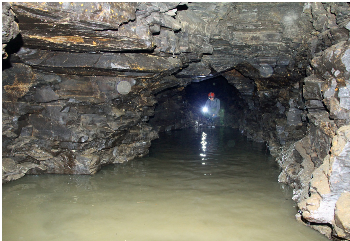
Hlavná chodba v štôlni, ktorá býva zatopená do výšky 2,5 m (tmavšia časť bridlíc). Strop je vo výške do 3,5 m (foto J. Madarás)
