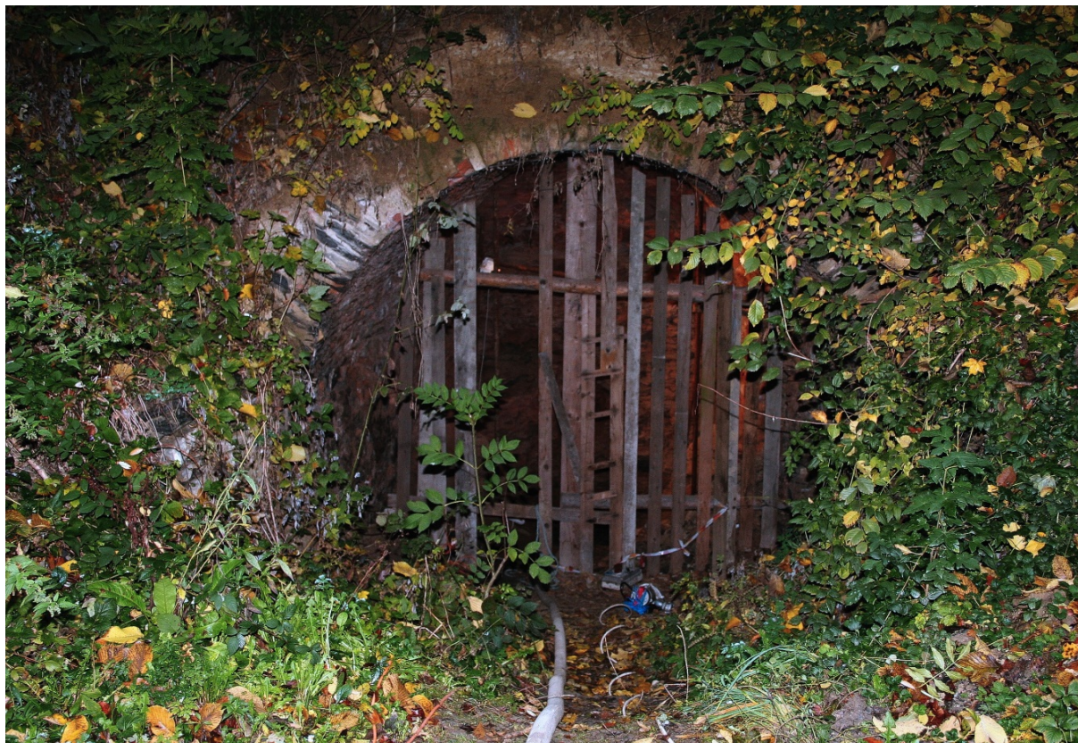
Súčasný stav vstupného otvoru opustenej pivnice za III. marianskou kaplnkou (foto J. Král)
