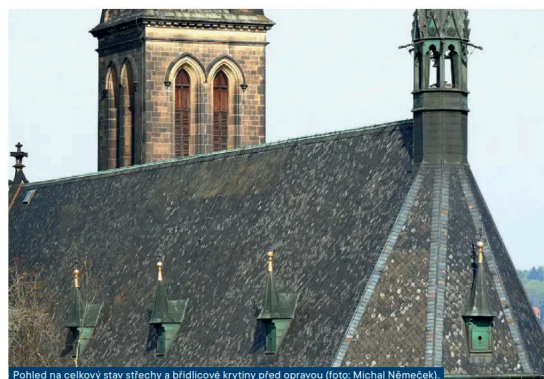
Pohled na celkový stav střechy a brádicové krytiny před opravou (foto: Michal Němeček).
