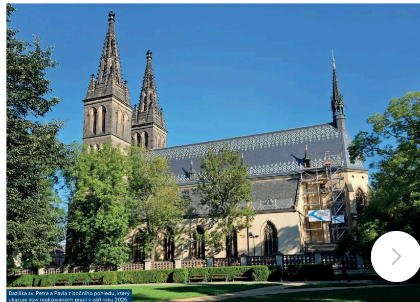
Bazilika sv. Petra a Pavla z bočního pohledu, který ukazuje stav realizovaných prací v září roku 2025.
